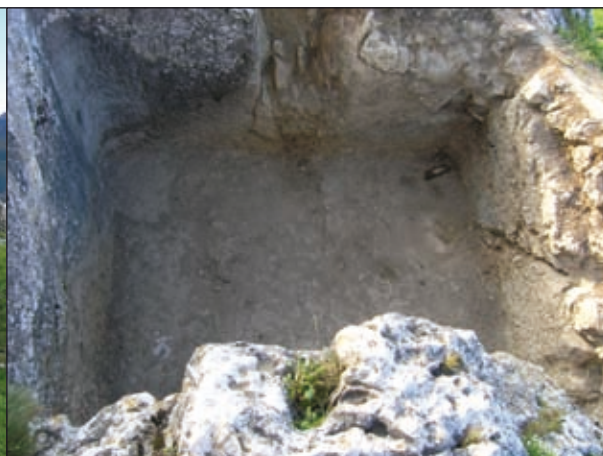
Aljibe antes y después de la excavación.
