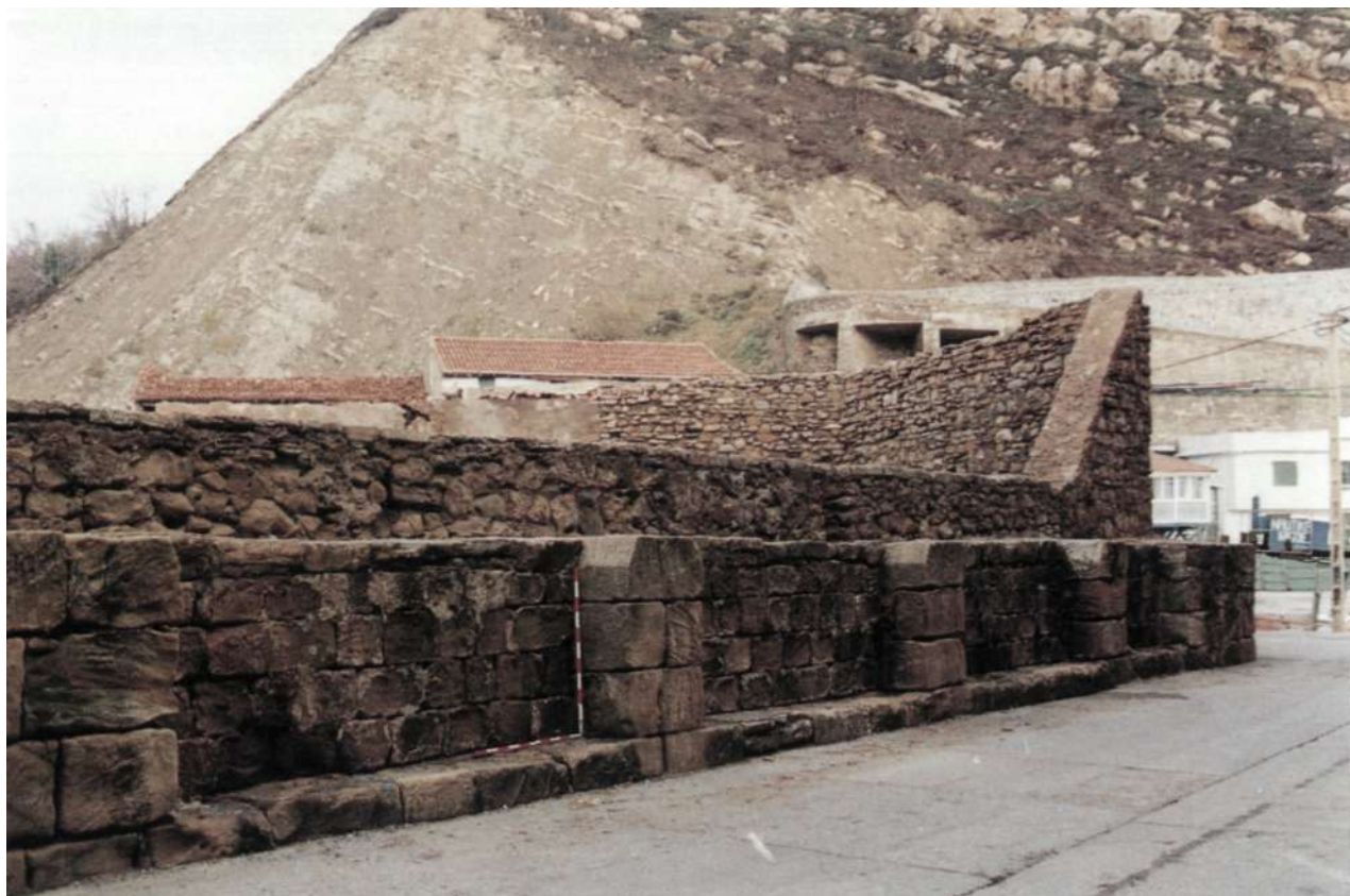
Zona portuaria de Getaria. Escalones de sillería del muro principal.
