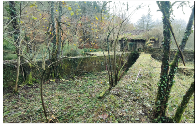
A la derecha, vista de la antepara ubicada en la franja oriental. A la izquierda, arco de salida de la estolda y canal de desagüe.
