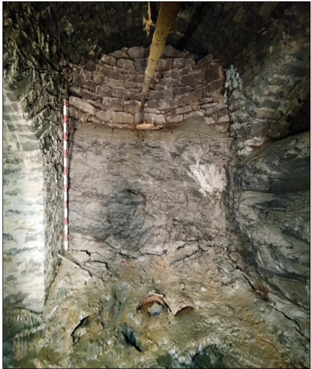
A la izquierda, interior de la mitad occidental del aljibe. A la derecha, extremo occidental del aljibe, terminado en bóveda de horno. Puede verse parte del tubo que evacuaba el agua hacia la propiedad de Urrutia.
