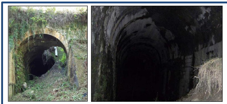
Figura 5. túnel de ARROA. primer derrumbe boca salida.
