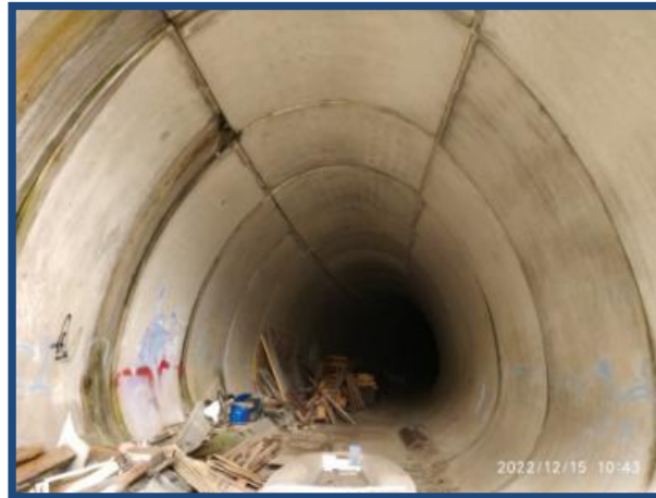
Figura 3. Túnel de Arroa. Falso túnel prefabricado
