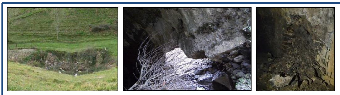
Figura 6. Túnel de ARROA. segundo derrumbe boca salida.
