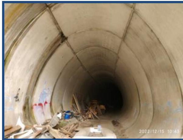
Figura 3. Túnel de Arroa. Falso túnel prefabricado
