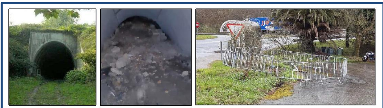
Figura 4. Túnel de Arroa. Boca de entrada.
