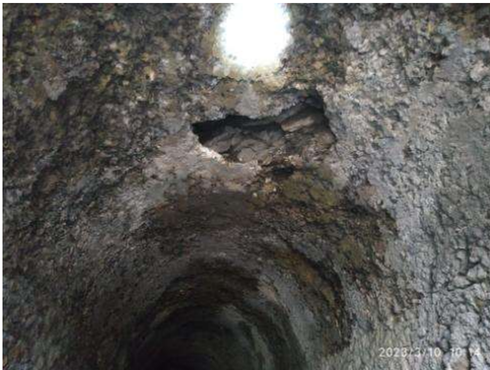
Figura. 15. Chimenea en clave (PK 9+526) y lavado de mampostería.
