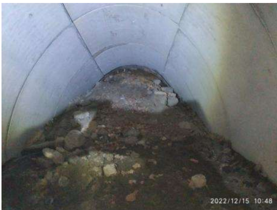
Figura. 19. Desprendimiento final falso túnel-comienzo túnel en mina (PK 9+843)
