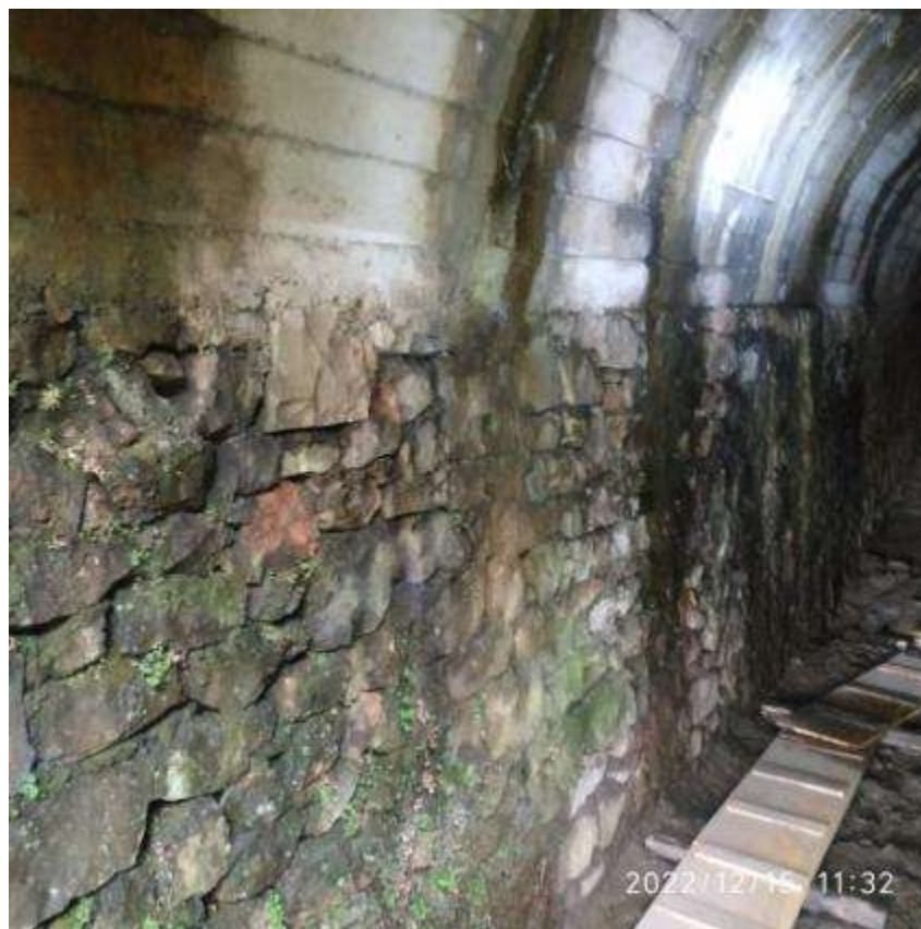
Figura. 23. Estado mampostería falso túnel salida
