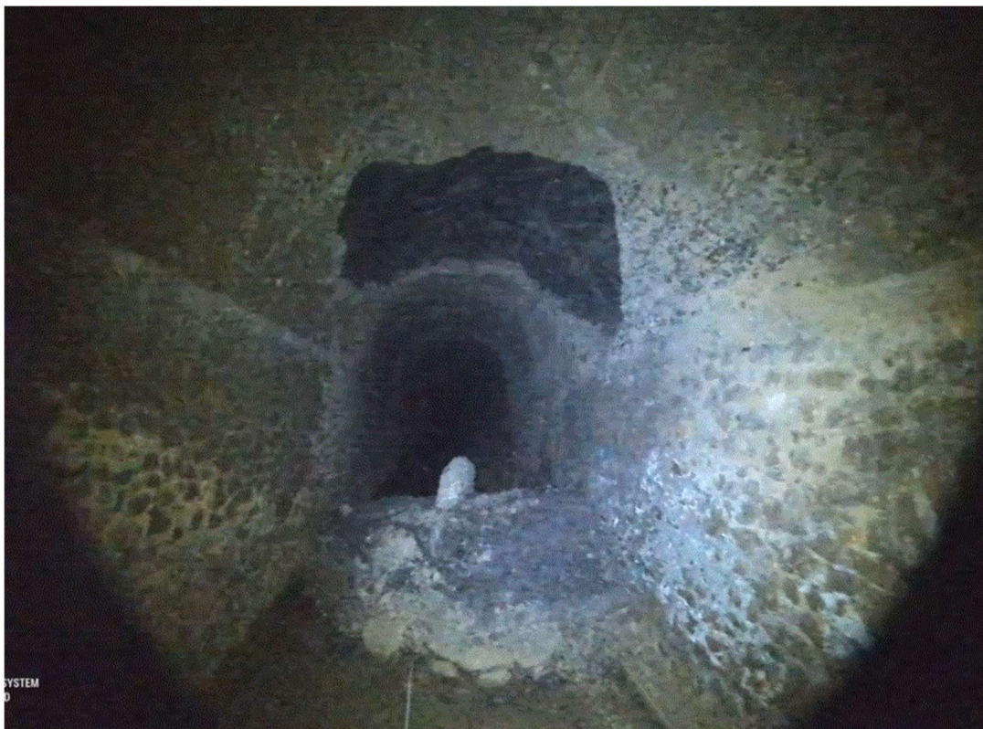
Figura. 20. Desprendimiento clave (PK 10+200)
