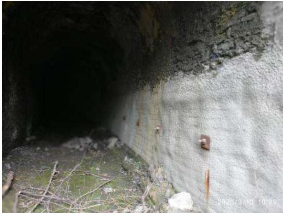
Figura. 16. HMP+bulones sobre mampostería, hastial derecho.
