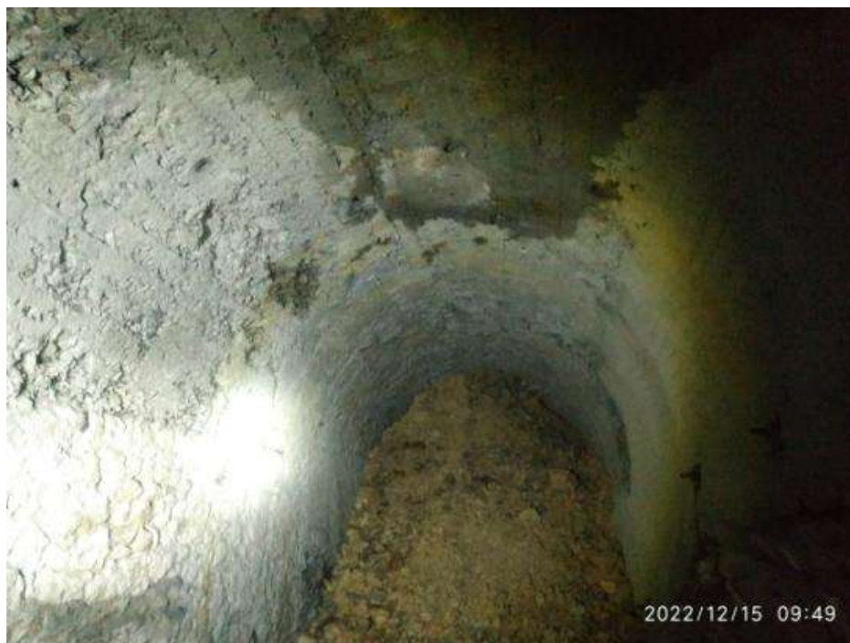
Figura. 4. Desprendimiento túnel en mina (Iraeta)
