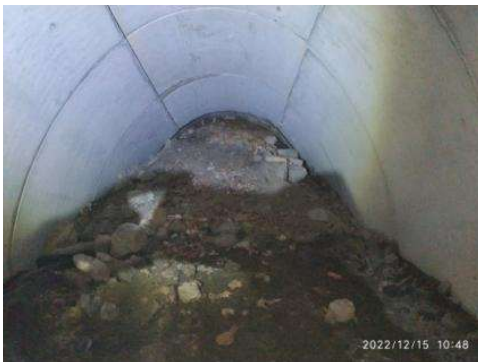
Figura. 8. Relleno y hundimiento final falso túnel (Arroa)
