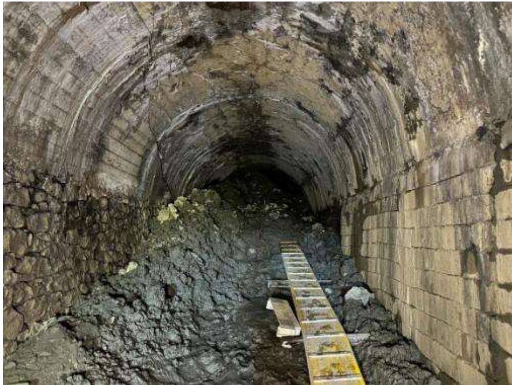
Figura. 24. Desprendimiento entronque túnel en mina-falso túnel
