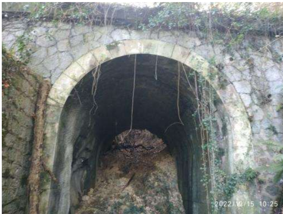
Figura. 5. Desprendimiento y falso túnel boca salida (Iraeta)
