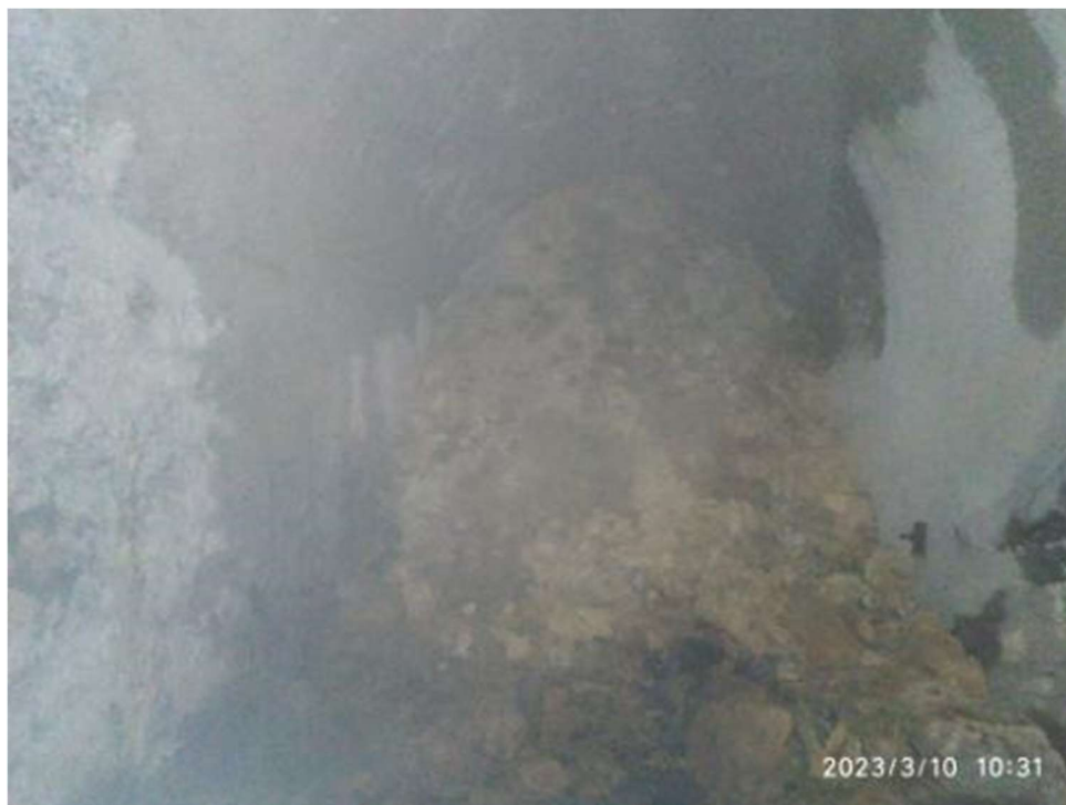
Figura. 17. Desprendimiento fondo túnel.
