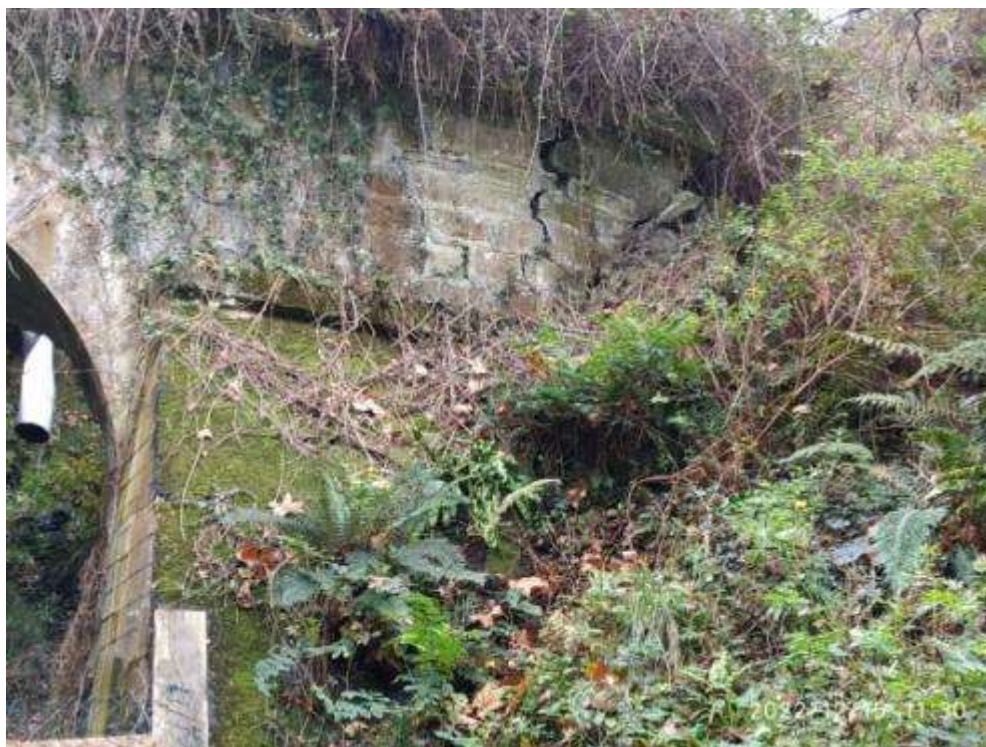
Figura. 22. Grietas en falso túnel de salida
