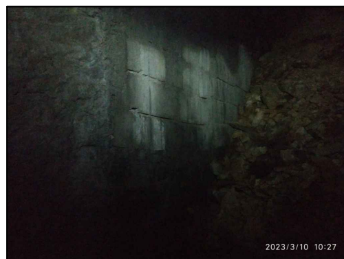
FOTO 4. BLOQUES DE HORMIGÓN FT P.K. 9+570
