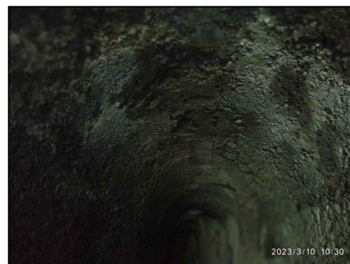
FOTO 3. MAMPOSTERÍA CLAVE LAVADO P.K. 9+550
