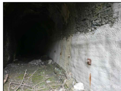
FOTO 2. HMP + ANCLAJES P.K. 9+525
