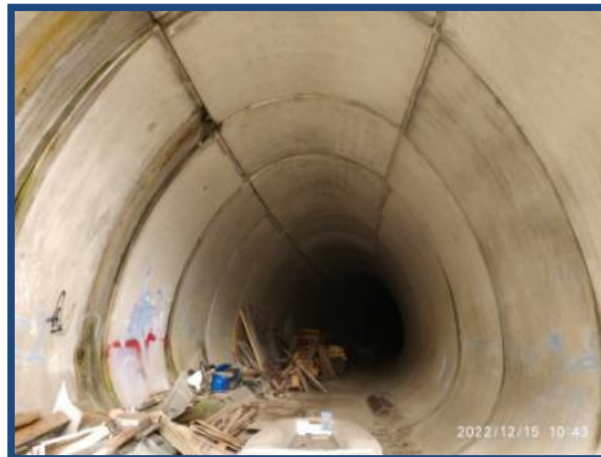
Figura 3. Túnel de Arroa. Falso túnel prefabricado
