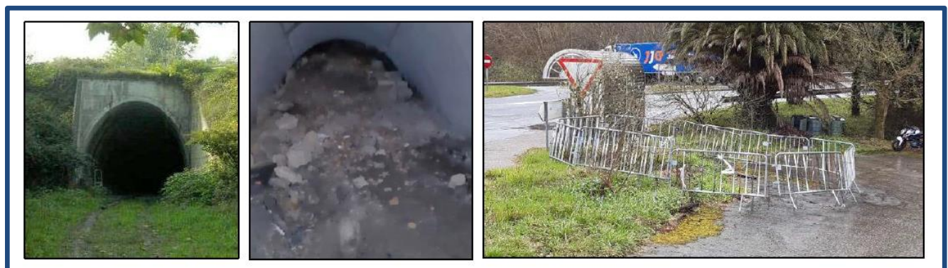
Figura 4. Túnel de Arroa. Boca de entrada.
