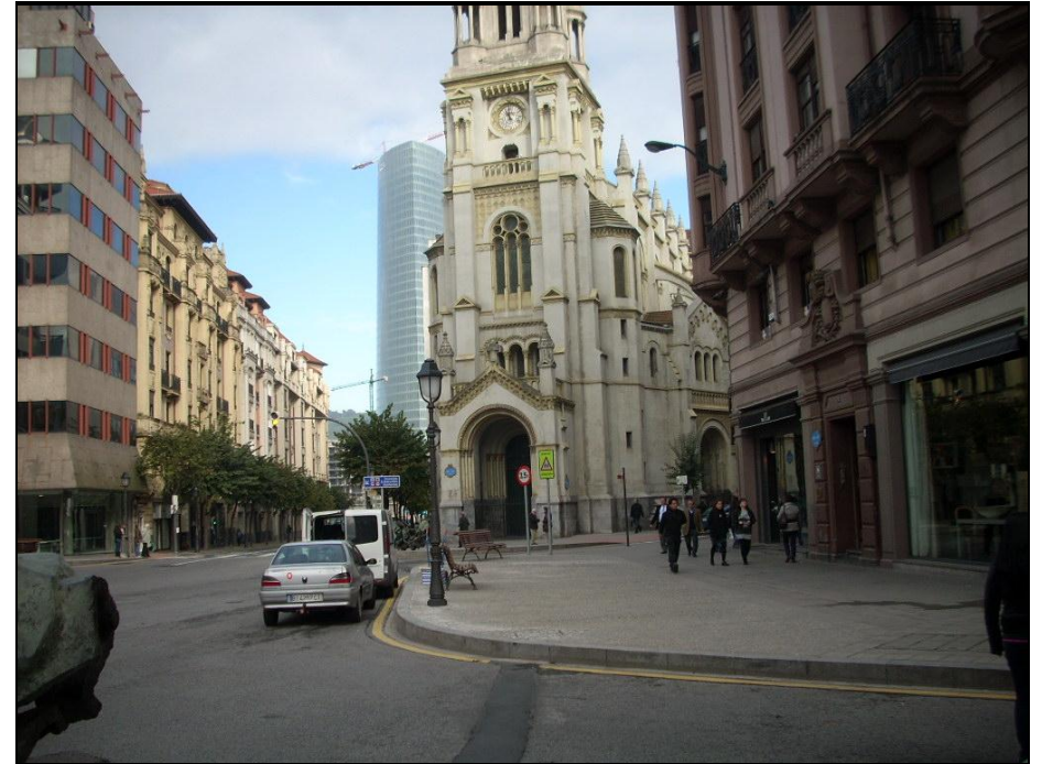
Foto 14. Plaza San José, en la acera se proyectan las escaleras de acceso a la estación..
