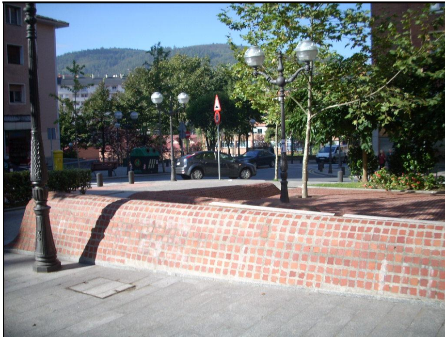
Foto 23. C/ Eskurtze, plazoleta donde se proyecta el otro acceso a la línea 4 del metro.
