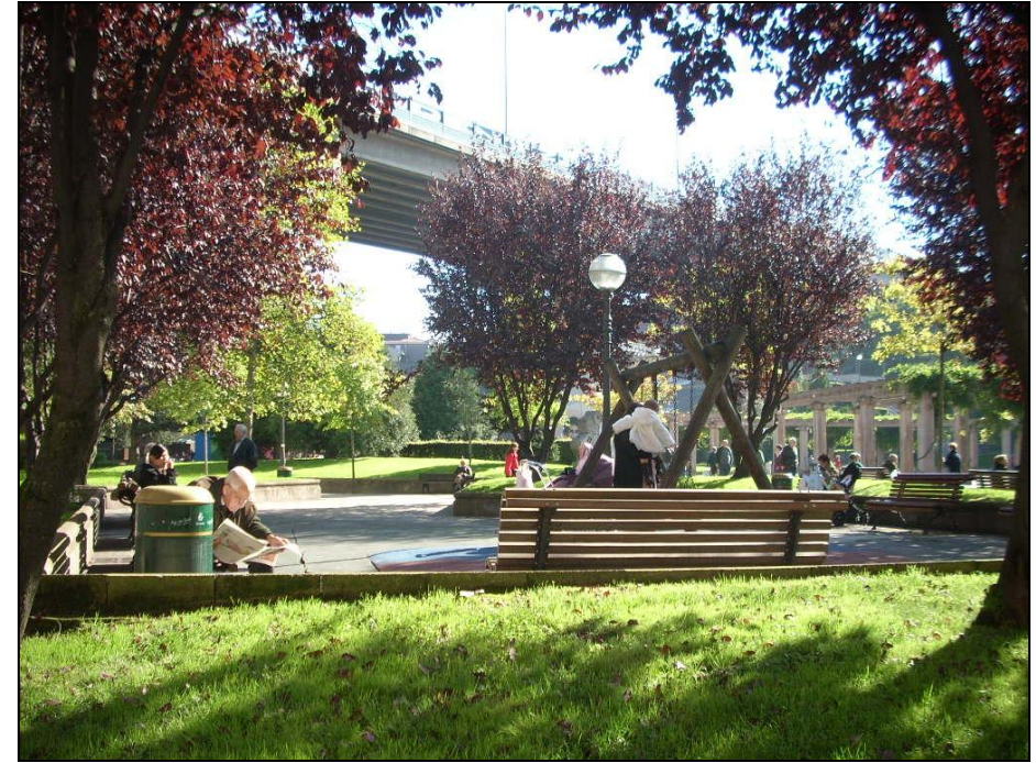
Foto 26. Zona de la plaza de Rekalde donde se construirá a cielo abierto la subestación eléctrica que alimentará la línea 4 del metro, para después soterrarla..
