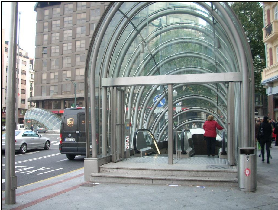
Foto 15. Cañones de acceso de la plaza Moyúa que serán afectados temporalmente durante las obras a cielo abierto de la estación proyectada bajo la citada plaza.
