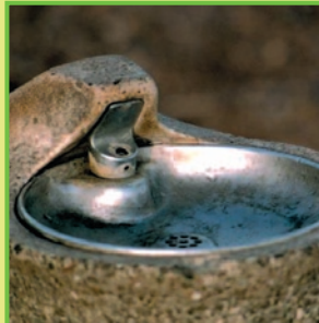
Dosifikatzailearen txorroitei esker askoz ere ur gutxiago gastatzen da.
