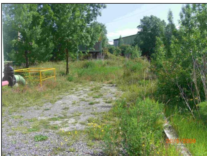
Foto 5. Vista de vegetación junto a instalación auxiliar en UR 5.
