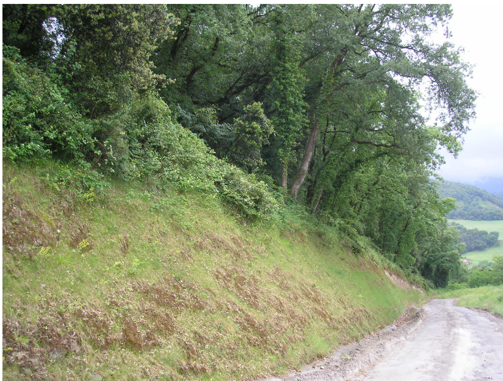
Figura 14. Actual camino de acceso en la zona suroeste del vertedero.
