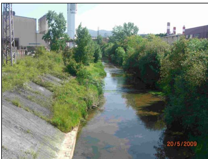
Foto 3. Vista general del talud en UR 3.
