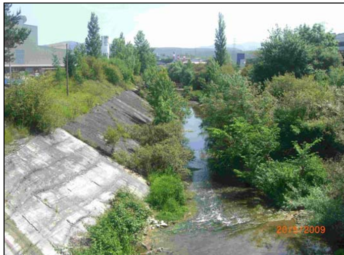
Foto 2. Detalle talud y vegetación en UR 3.
