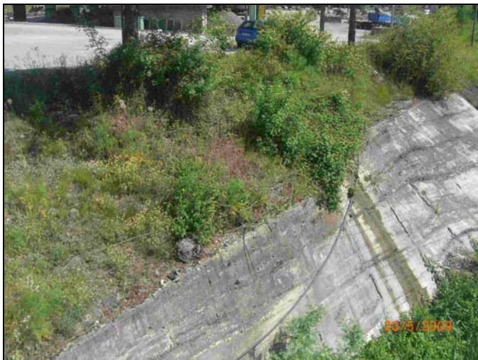
Foto 1. Detalle talud en UR 2.
