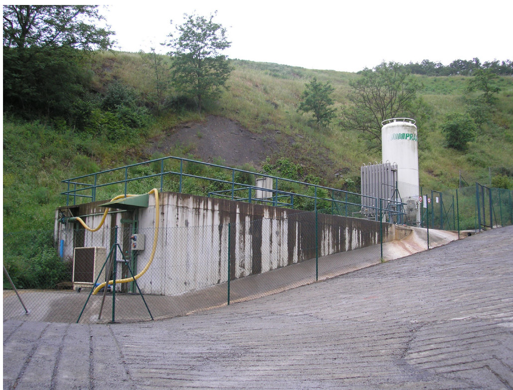
Figura 16. Planta de tratamiento de lixiviados.
