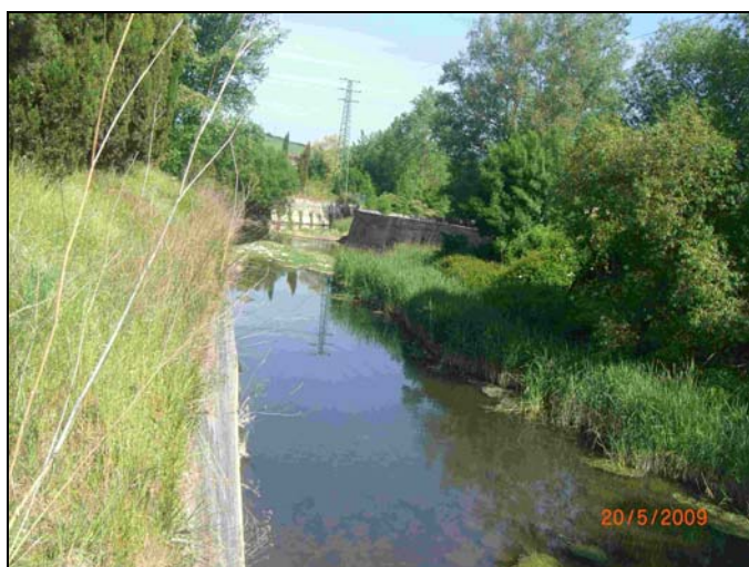
Foto 12. Muros verticales de hormigón en UR 8.
