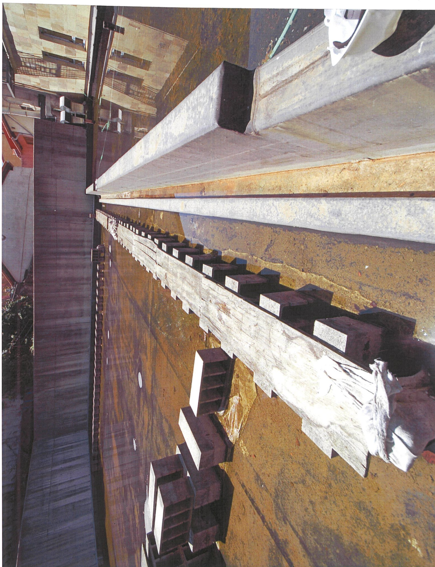
F 17 :TERRAZA INFERIOR PASARELA LONGITUDINAL
