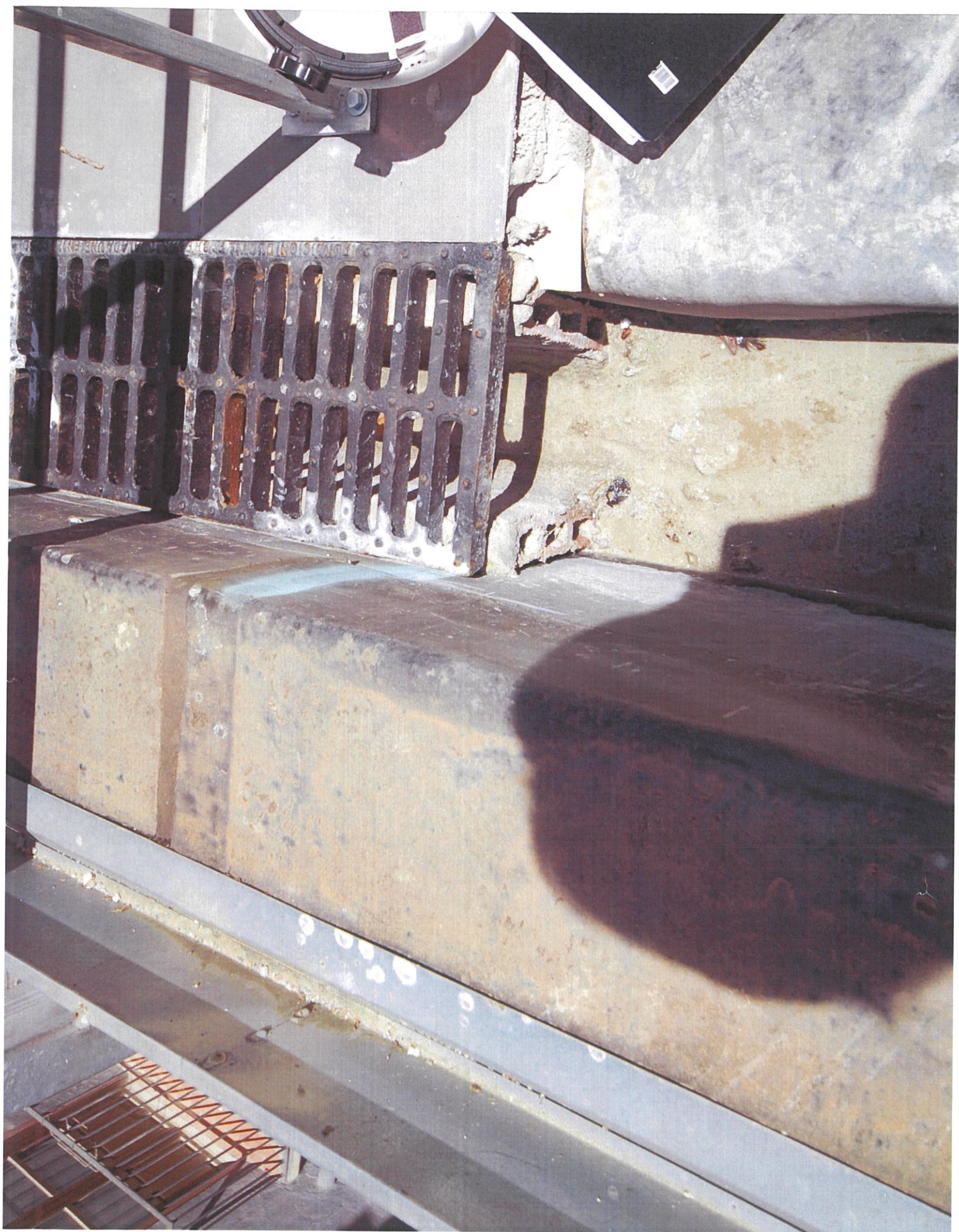
F 26 :TERRAZA FRONTON DETALLE REJILLA DESAGUE TERRAZA
