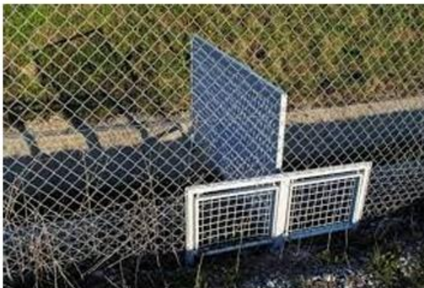
Figura 21. Ejemplo de portillo basculante para el paso de fauna.
