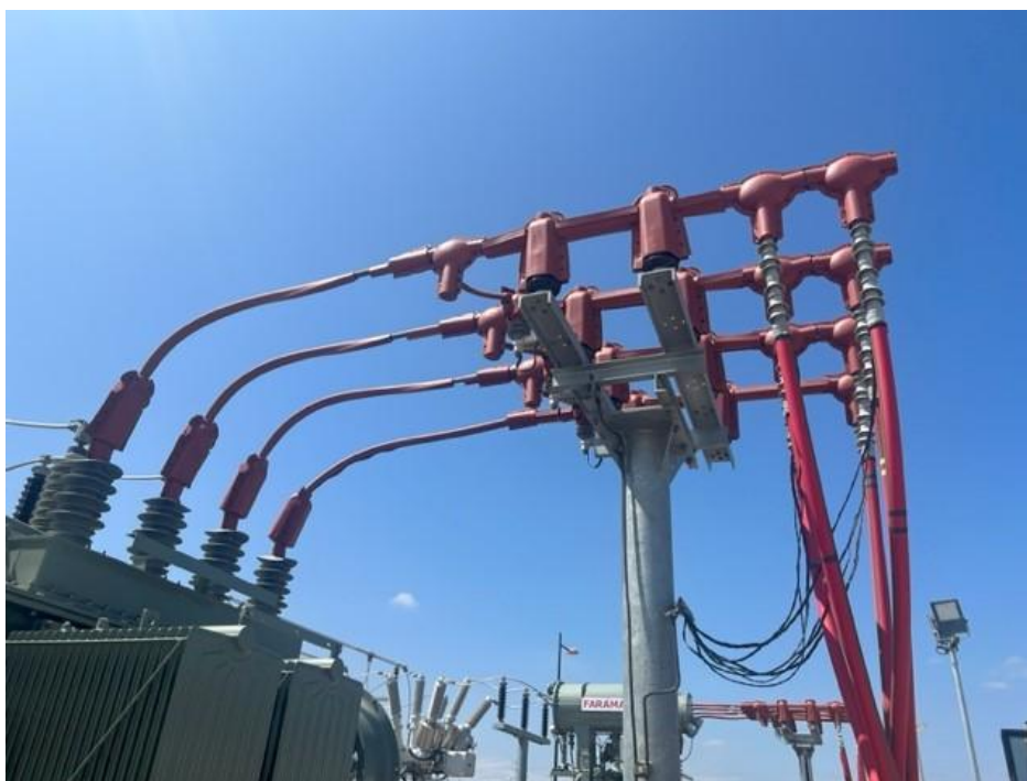
Figura 22. Ejemplo de dispositivo aislante anti-electrocución en embarrado de SET.
