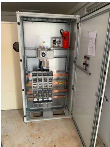
Ilustración. Envoltorio metálico del CGBT
