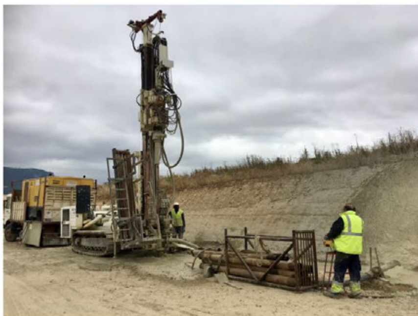
Fotografía 2. Maquinaria de perforación a rotopercusión tipo para perforar Artika-A.
