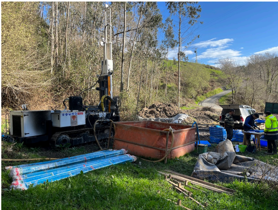
Fig. 4.1.- Equipo de perforación sondeo ARTIKA-1.
