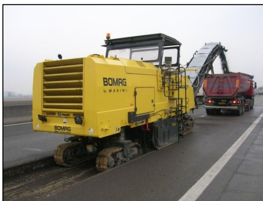
Imagen 4. Operación de fresado de asfalto.
