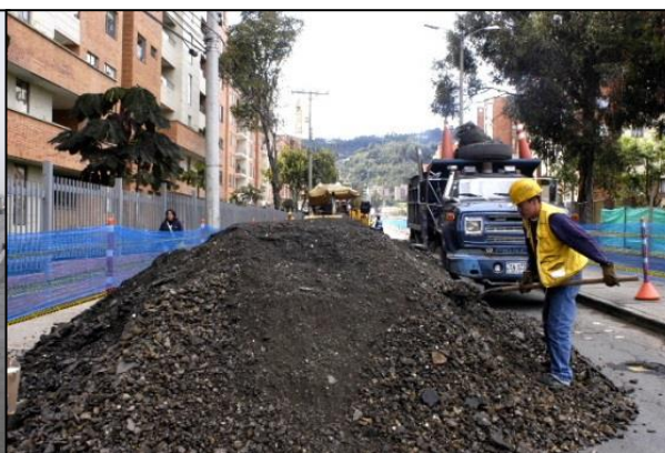
Imagen 5. Residuo de fresado de asfalto.
