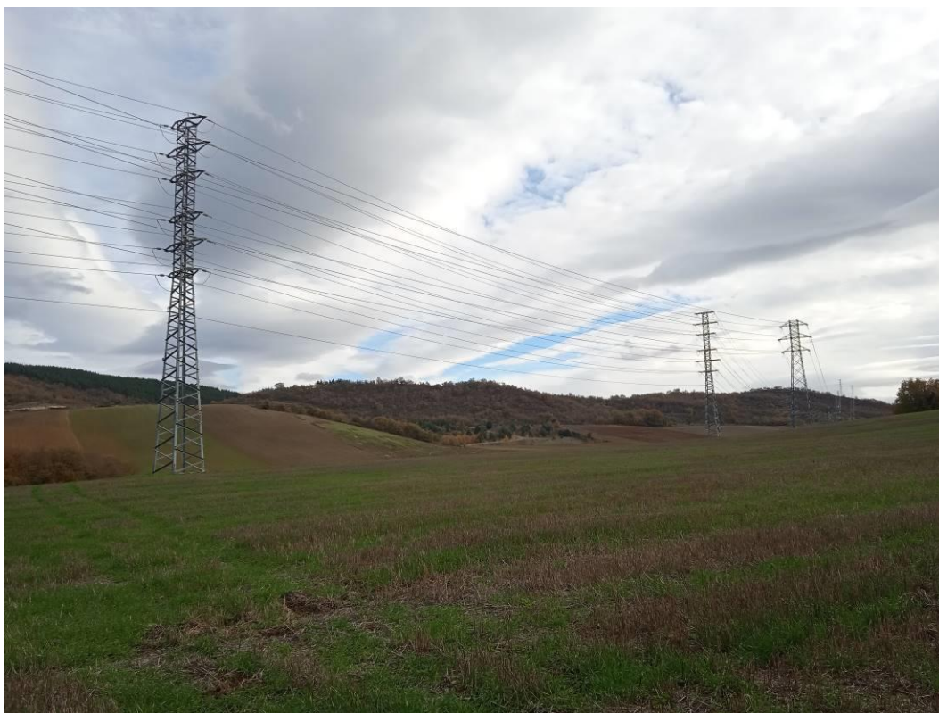
Figura 2.- Inicio del tramo existente (junto a la ST Elgea) con conductores tipo LA-280 fuera de servicio que se utilizarán para la nueva línea eléctrica proyectada
