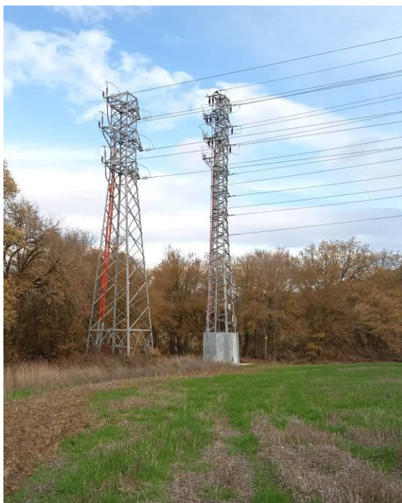
Figura 3.- Apoyo nº1 existente (a la derecha) en el que se instalarán dos nuevos OCR
