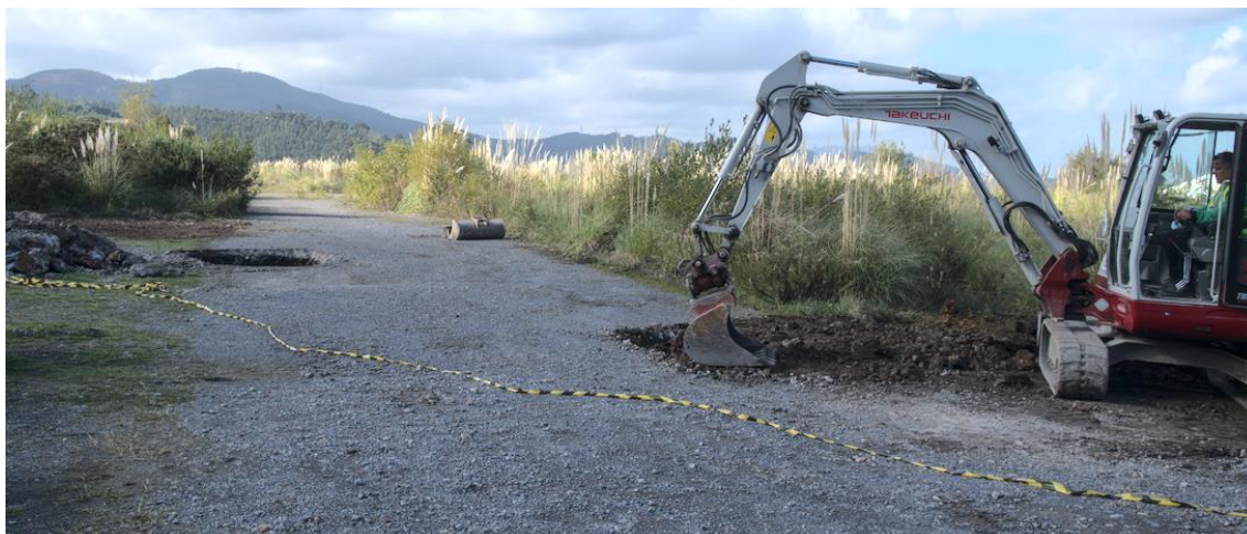
Imagen 21. Trabajos de excavación y toma de muestras para la caracterización del material de relleno existente. Elaboración propia
