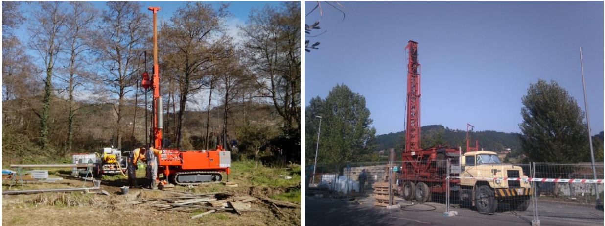
Fotografía 1. Maquinaria tipo para perforar los piezómetros Urberuaga-1 y 2 (izquierda) y maquinaria de perforación a percusión tipo para perforar Urberuaga-A (derecha).
