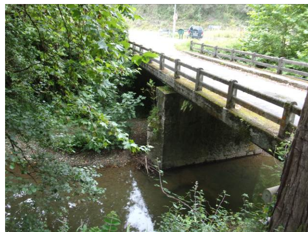
Fotos 21 y 22.- Puente Balneario 1 (Cod. nº 163 CPCV) / Puente Urberuaga (Cod. nº 70 PGOU). Detalles del tablero y pretil (a la izquierda) y de la pila y el tajamar (a la derecha)
