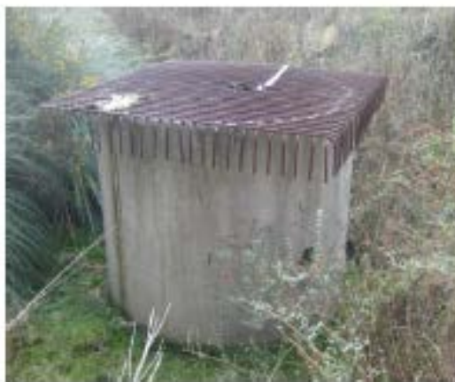
Pozo de control existente dentro del relleno.
