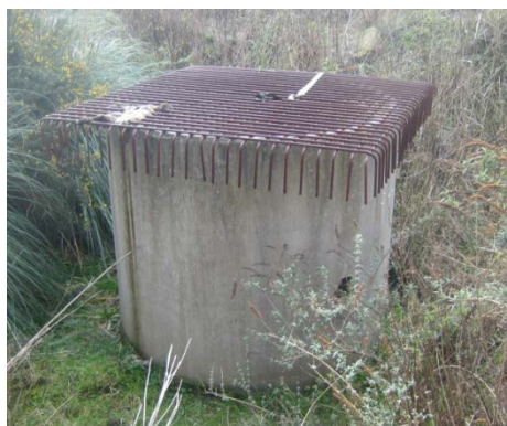
Pozo de control existente dentro del relleno.
