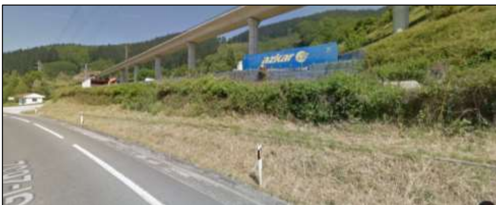
Imagen 4: Frente sur de la parcela desde la carretera GI-2632.
