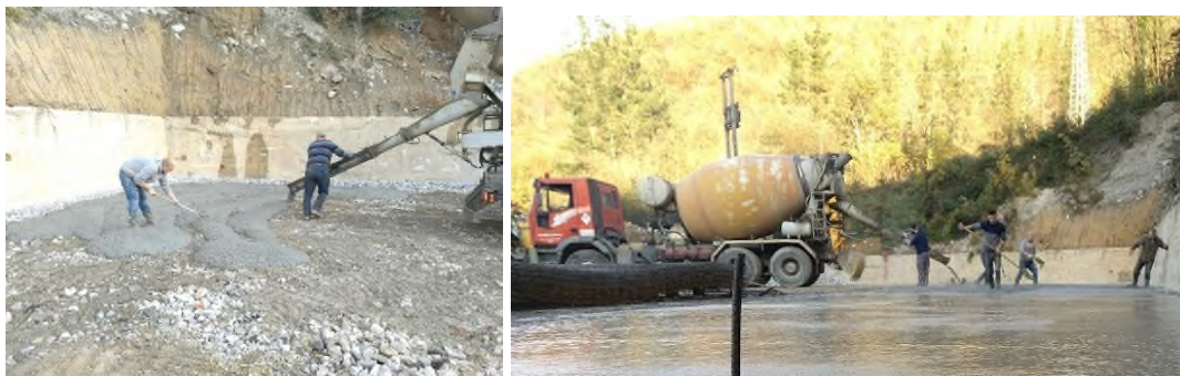
Trabajos de impermeabilización de la parcela
