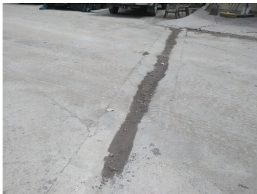
Cuneta de recogida de pluviales
