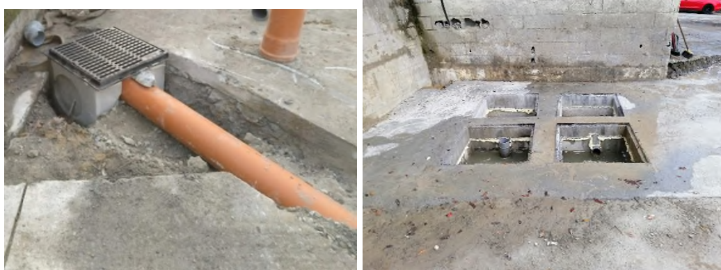
Instalación de la arqueta separadora de aceites y grasas
