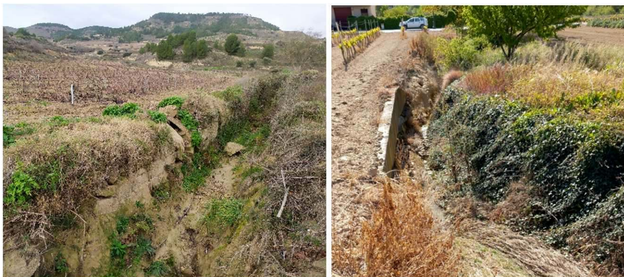
Figura 2: Aspecto actual del cauce con paredes verticales y muros de hormigón
