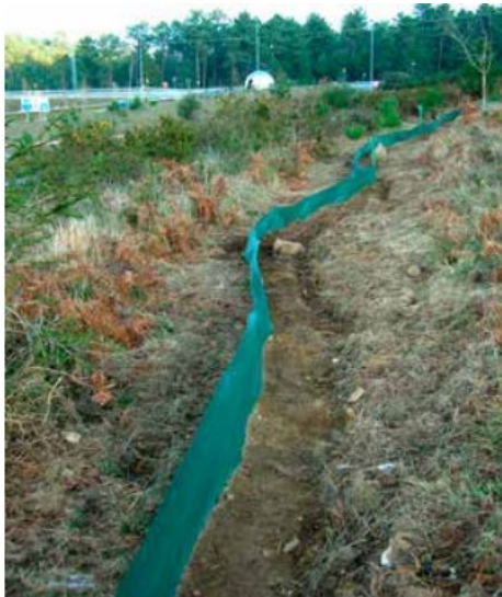
Figura 11.8. Barrera temporal que se combina con cubos de recogida. Foto: Oficina de Medio Ambiente, Universidad de Vigo.
