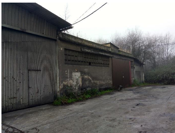
Elementos a derribar con fibrocemento y presencia de Buddleja davidii y Cortaderia selloana. Restos de basuras y fibrocementos en la sauceda
