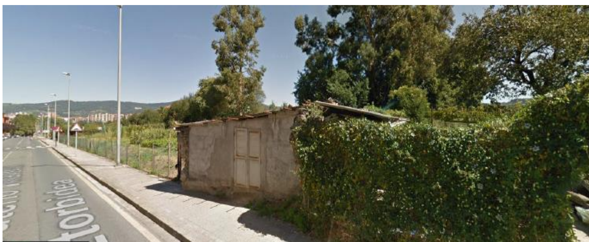
Imagen 9: Edificación a demoler
