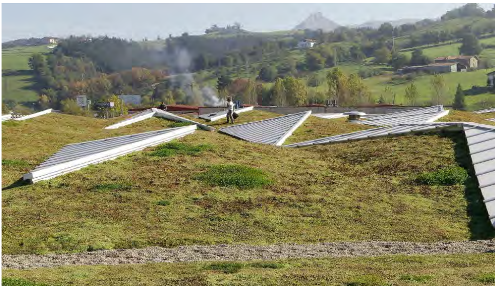
Imagen 006: Cubierta verde en una nave de mecanizado industrial de Ampo, Idiazabal, Guipúzcoa. Fuente: https://www.interempresas.net/Instaladores/Articulos/213156-Knauf-Insulation-instala-una-cubierta-verde-de-6800m2-en-Guipuzcoa.html
