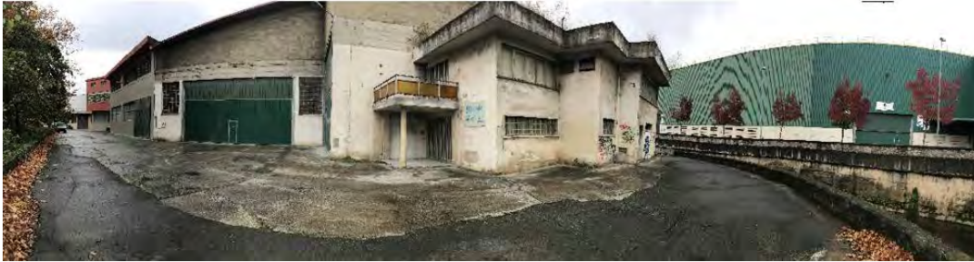
Nave de Mármoles Aramendi, junto al río.
