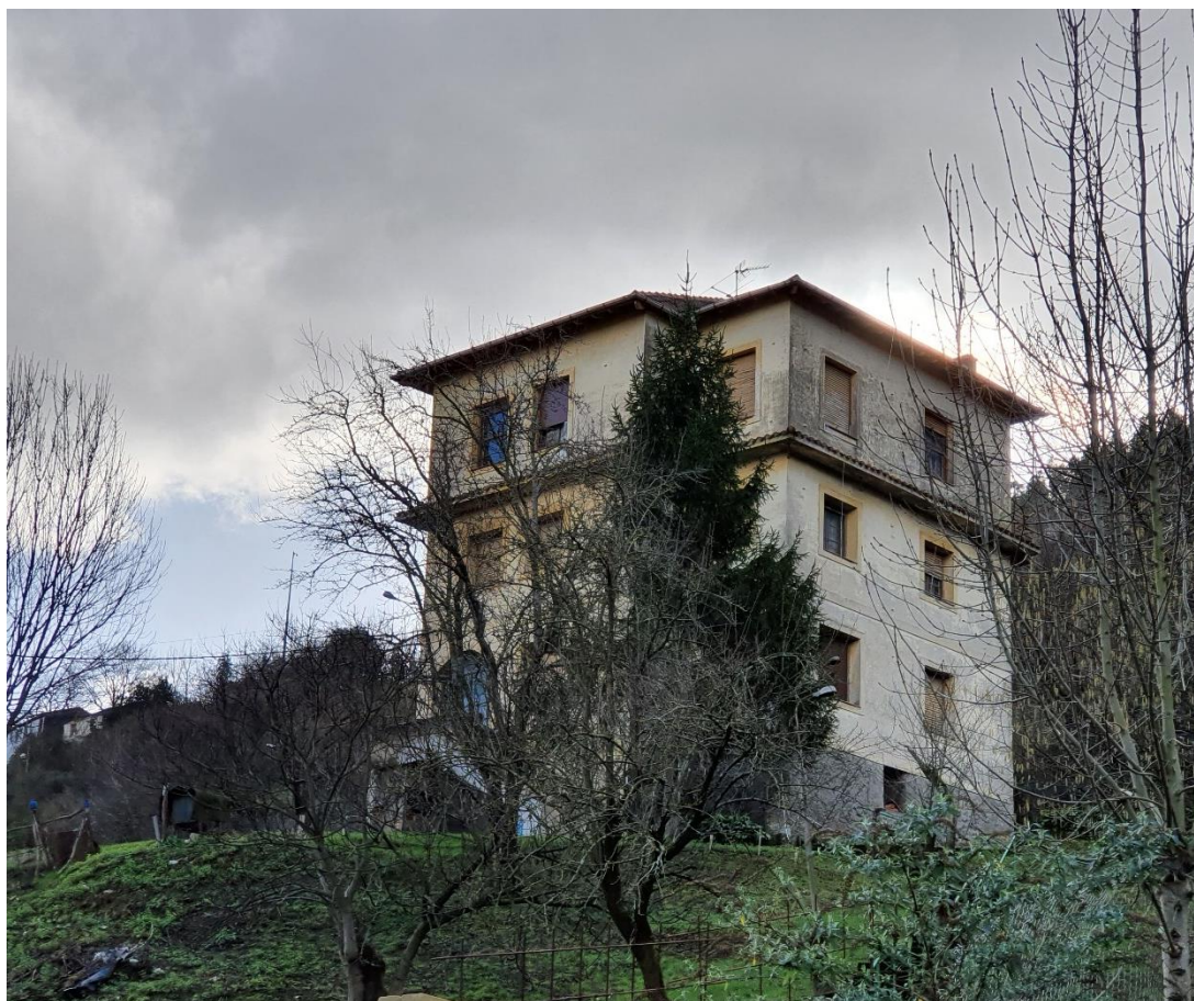
Imagen: edificación fuera de ordenación
