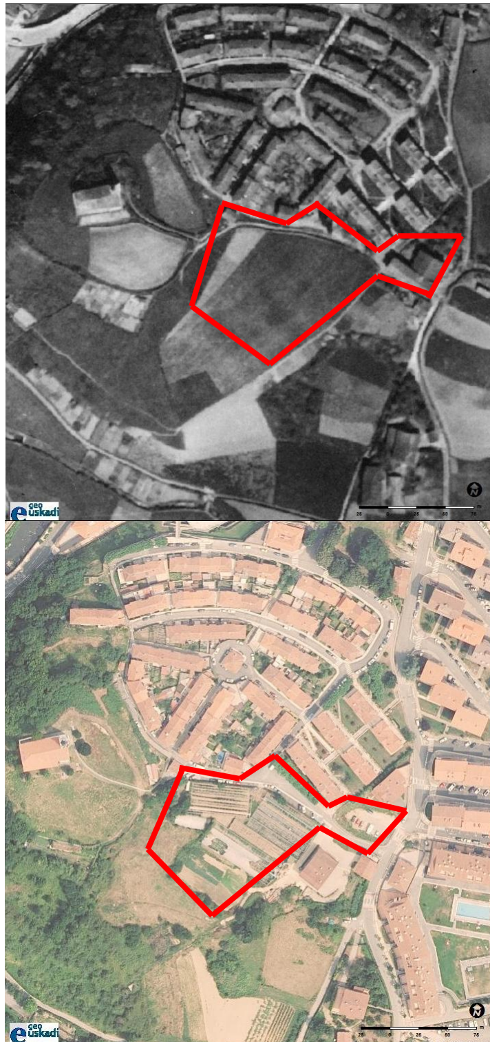
Ortofoto comparativa de la evolución del emplazamiento de las Unidades de Ejecución UE2-AU2 (Vuelos de 1954 y 2019) (FUENTE: Geoeuskadi)
