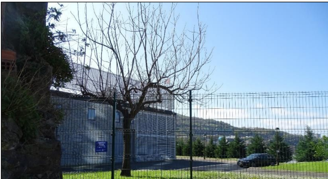
Foto 5. Vista de la parte delantera del sub-ámbito 2
