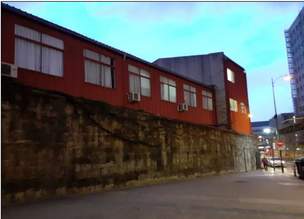
Foto 9. Actual edificio de la facultad de medicina que se pretende sustituir
