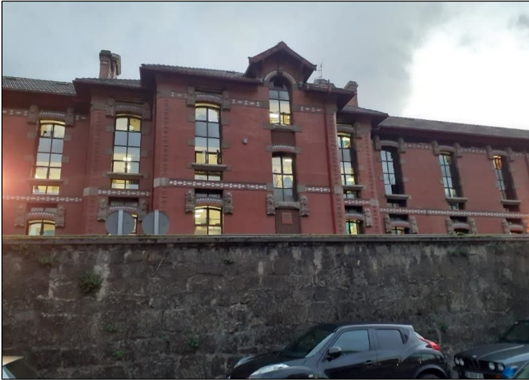
Foto 8. Edificio Revilla y muro perimetral del conjunto protegido del Hospital
