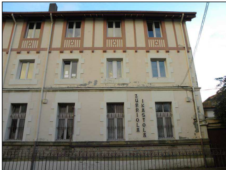
Figura 1. Vista general de la Ikastola Zurriola, por su fachada norte (Fuente: Elaboración propia).
