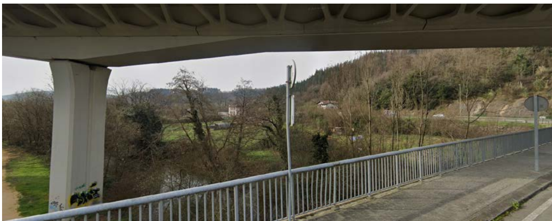
Doble cruce de infraestructura sobre el río Arratia en Igorre
