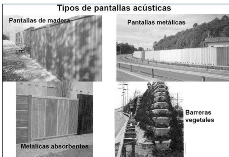
Imagen 19: Tipos de pantallas acústicas
