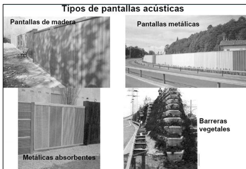
Imagen 19: Tipos de pantallas acústicas
