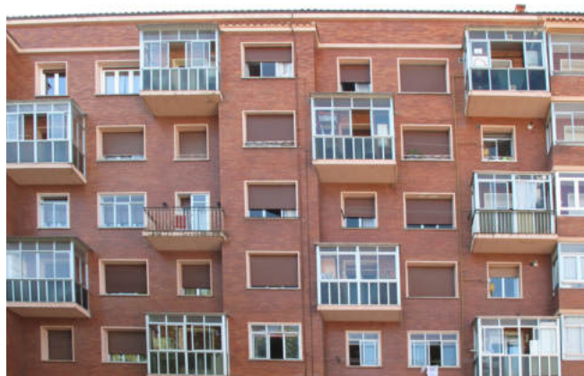
Figura 126. Fachada con varios balcones cerrados mediante cerramientos acristalados de aluminio, que alteran completamente el volumen original del edificio. Fuente: elaboración propia.
