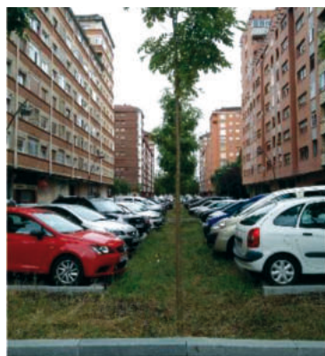
Figura 142. Ejemplo de diseño de un área inundable de bio-retención (jardín de lluvia) adyacente a un pasillo de estacionamiento en la Calle Voluntaria Entrega de Vitoria-Gasteiz. Fuente: elaboración propia
