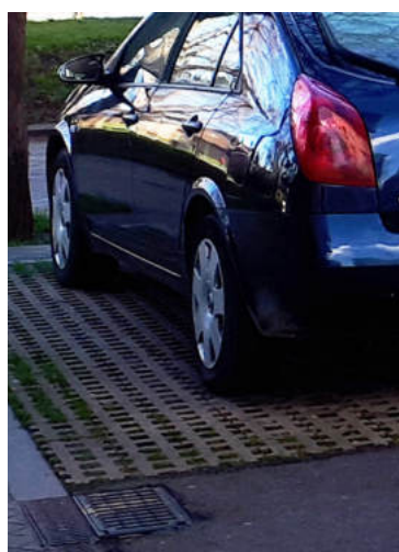
Figura 141. Algunos tipos de pavimento permeable (izq.) y ejemplo de la implementación de la rejilla de césped en el barrio de Zaramaga, Vitoria-Gasteiz (dcha.). Fuente: Toronto City Planning, 2013 (izq.) y elaboración propia (dcha.)
