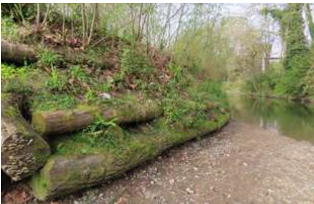
Figura 42. Restauración muro krainer. Fuente: elaboración propia
