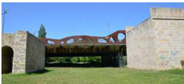
Figura 256. Hueco abierto en el puente viejo que coincide con el del puente nuevo, lo que amplía la capacidad hidráulica del conjunto. Fuente: elaboración propia
