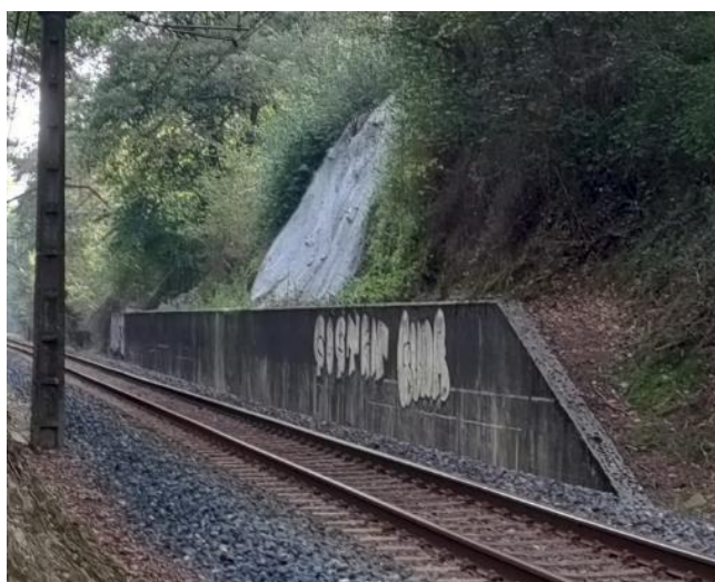
Ezpona bertikal gunitatua trenbidearen trazaduraren eta BI-635 errepidearen artean dagoen espazio eskasean kokatua (5 m-ko distantzia plataforma-ertzen artean eta 9 m-ko kota-aldea)
