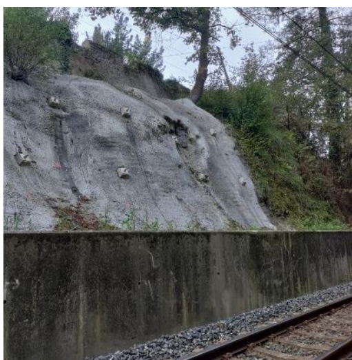
Ezpona bertikal gunitatua trenbidearen trazaduraren eta BI-635 errepidearen artean dagoen espazio eskasean kokatua (5 m-ko distantzia plataforma-ertzen artean eta 9 m-ko kota-aldea)
