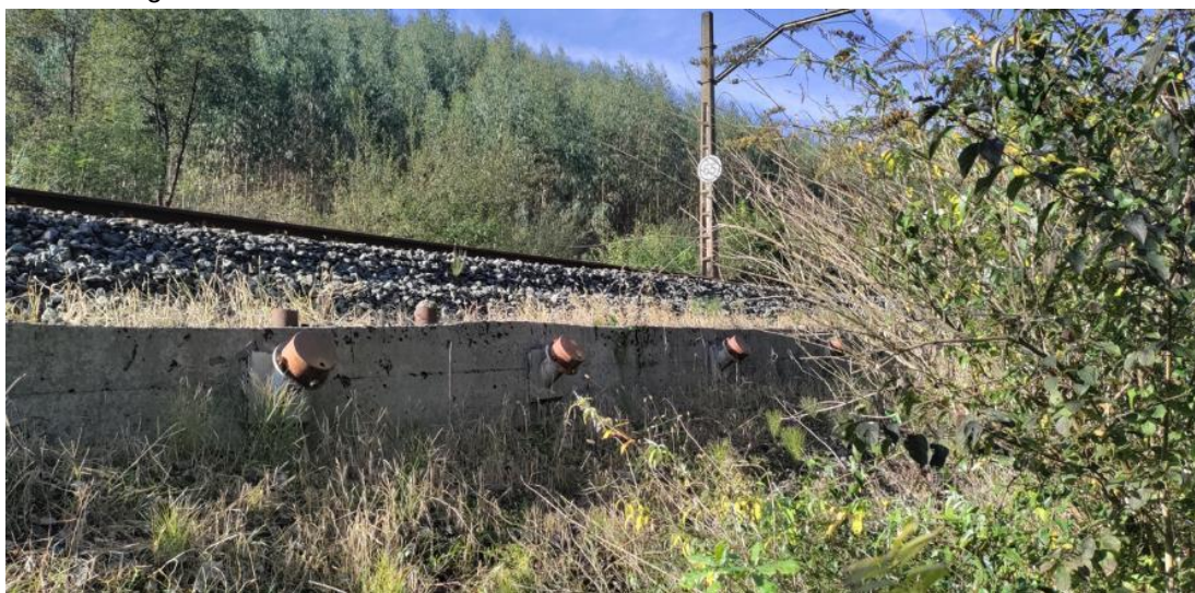
Mikropilotezko pantaila eta habe aingurua KP 4+700 eta el KP 4+740 artean
