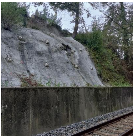
Talud vertical gunitado ubicado en el escaso espacio disponible entre trazado ferroviario y carretera BI-635
