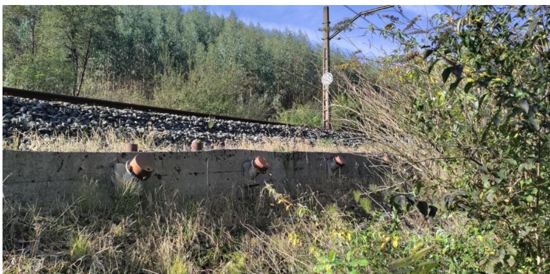
Pantalla de micropilotes y viga anclada entre el PK 4+700 y el PK 4+740
