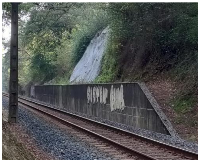
Talud vertical gunitado ubicado en el escaso espacio disponible entre trazado ferroviario y carretera BI-635
