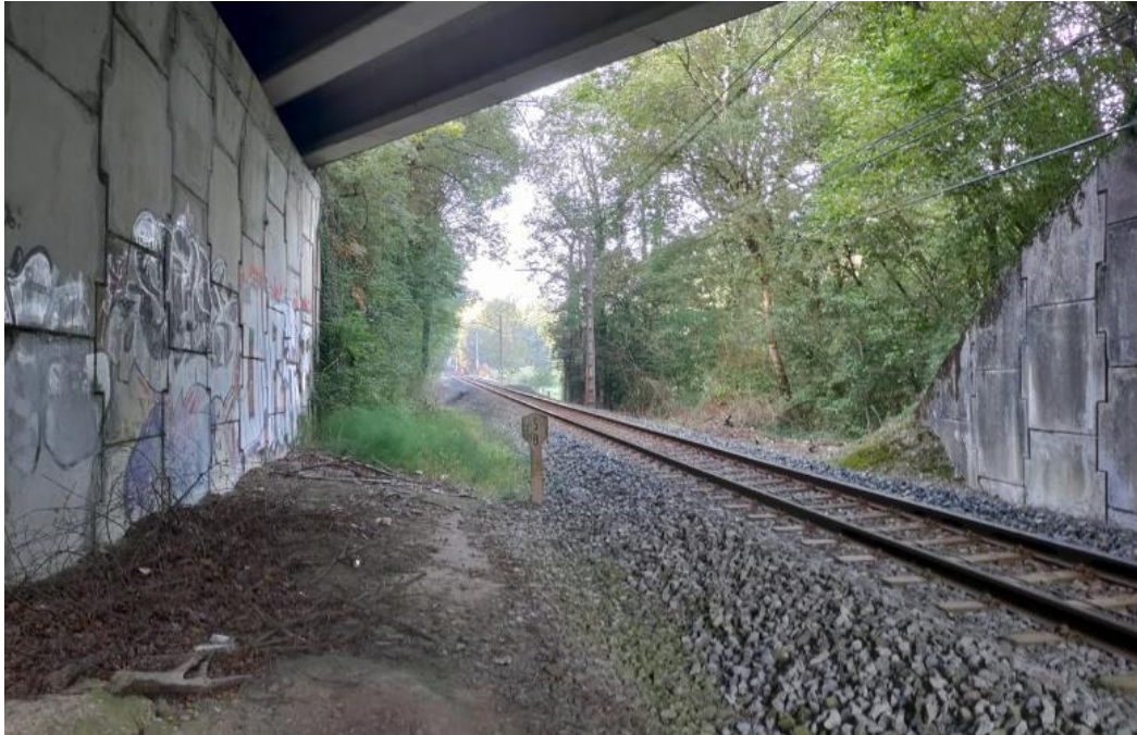
Sobreancho en el paso bajo la BI-635 existente para conexión longitudinal
