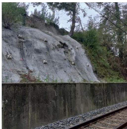
Talud vertical gunitado ubicado en el escaso espacio disponible entre trazado ferroviario y carretera BI-635 (distancia de 5 m entre bordes de plataforma y 9 m de diferencia de cota)
