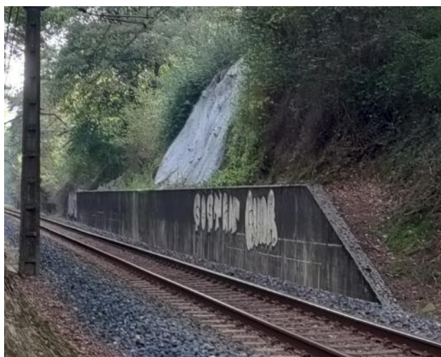
Talud vertical gunitado ubicado en el escaso espacio disponible entre trazado ferroviario y carretera BI-635 (distancia de 5 m entre bordes de plataforma y 9 m de diferencia de cota)
