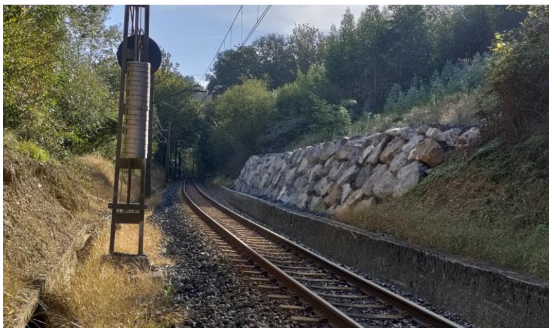
Escollera existente en el desmonte del PK 5+000
