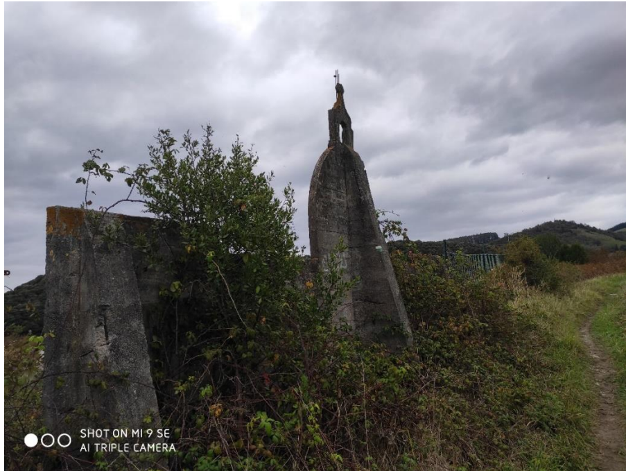
Figura 2. Presencia de maleza y matorrales junto a fachada o retablo junto a camino perimetral de ladera norte del monte Basusta.
