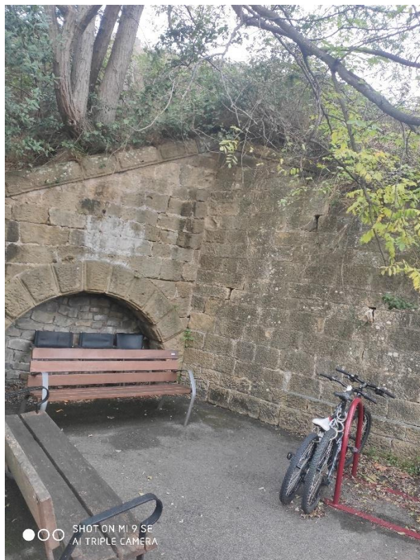
Figura 8. Paso inferior junto carretera Camino Basusta
