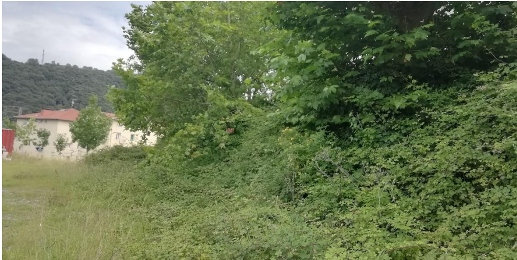
Figura 4. Arbolado en vías apartadero y zona de acopios de materiales de vía dentro de la plataforma de vía del ferrocarril.
