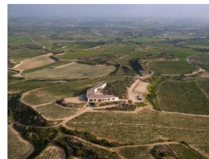
F1_VISTA AEREA CONJUNTO
