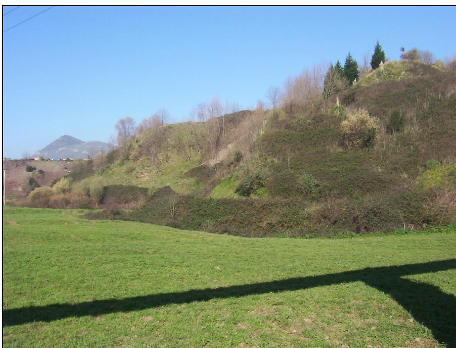
Aspecto del frente sur de la escombrera de Kabiezes.
