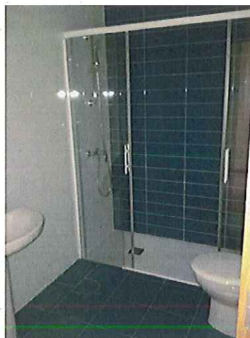
Colocación de Mampara definitiva
