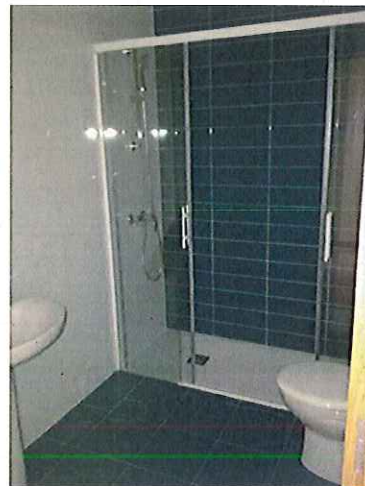
Colocación de Mampara definitiva
