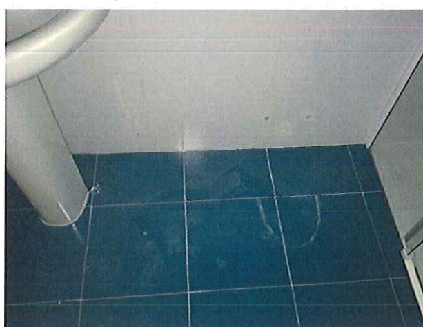
Han dejado visibles las llaves de paso de Bidet para futura colocación
