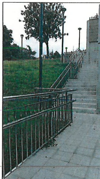
Barandilla de acero inoxidable en las escaleras que existen en el lateral de la Haurreskola.
