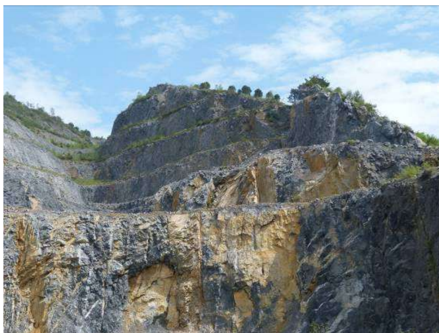
Foto 1 y 2. Bermas del área de ampliación de la cantera.
