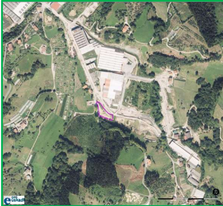
Figura 1. Vista de la zona objeto de estudio, en rosa el emplazamiento de i-DE en Zarautz.
