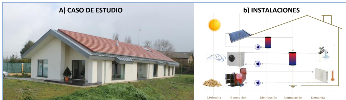
Figura 1. Vivienda unifamiliar monitorizada en Álava (a) y sus instalaciones de calefacción y ACS (b)
