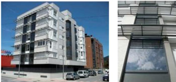
Figura 1. Edificio de 26 Viviendas Sociales y edificio gemelo comparativo en Durango y detalle del Muro Trombe.
