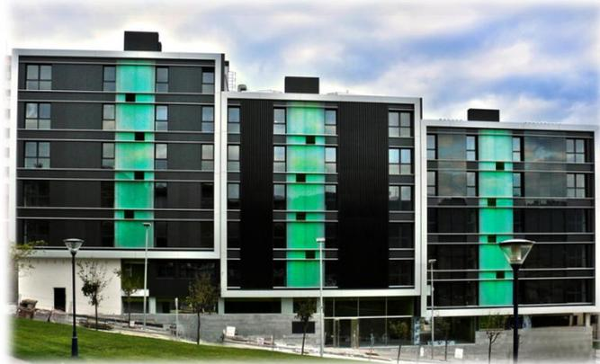
*Figura 2. Conjunto de 32 Viviendas Sociales ECCN en Portugalete (Bizkaia) y los tres sistemas de fachada sur: Panel sándwich aislante (izq), fachada SolarWall (centro) y fachada con Muro Trombe (dcha.).*
